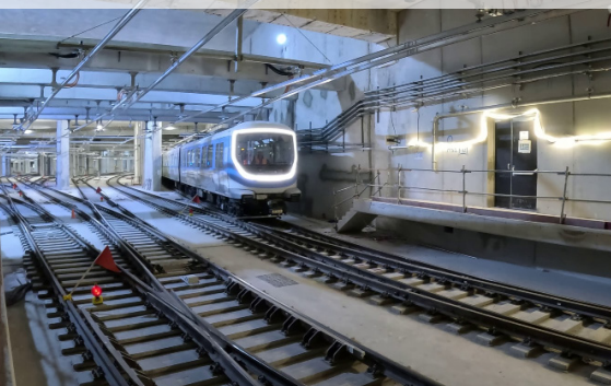
Premier roulage de la ligne 15 - 28/11/2023
