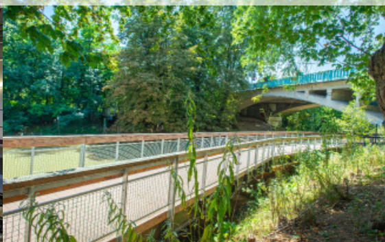
Passerelle piétonne - pont de Champigny
